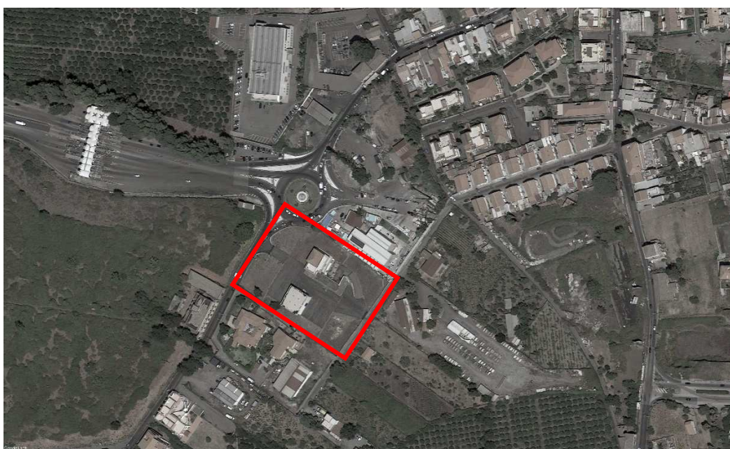
Figura 1_ Immagine satellitare del lotto oggetto di intervento. Maggio 2016. Fonte Google Earth
